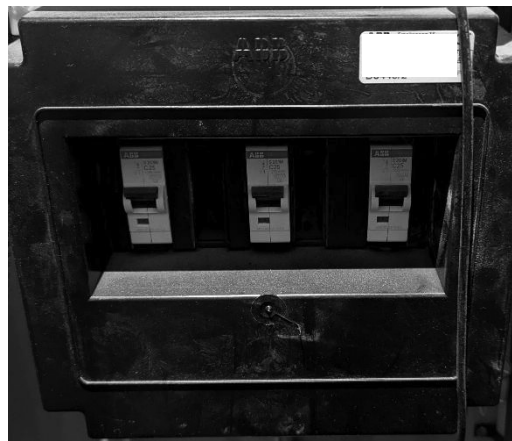
Figuur 3: Een hoofdzekering met verzegeling, met drie schakelautomaten. Beeld: Marten Witkamp
